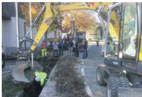
Für den Lückenschluss Wernersdorf musste das Glasfasernetz vom ECO-Park in das Ortszentrum verlegt werden.
